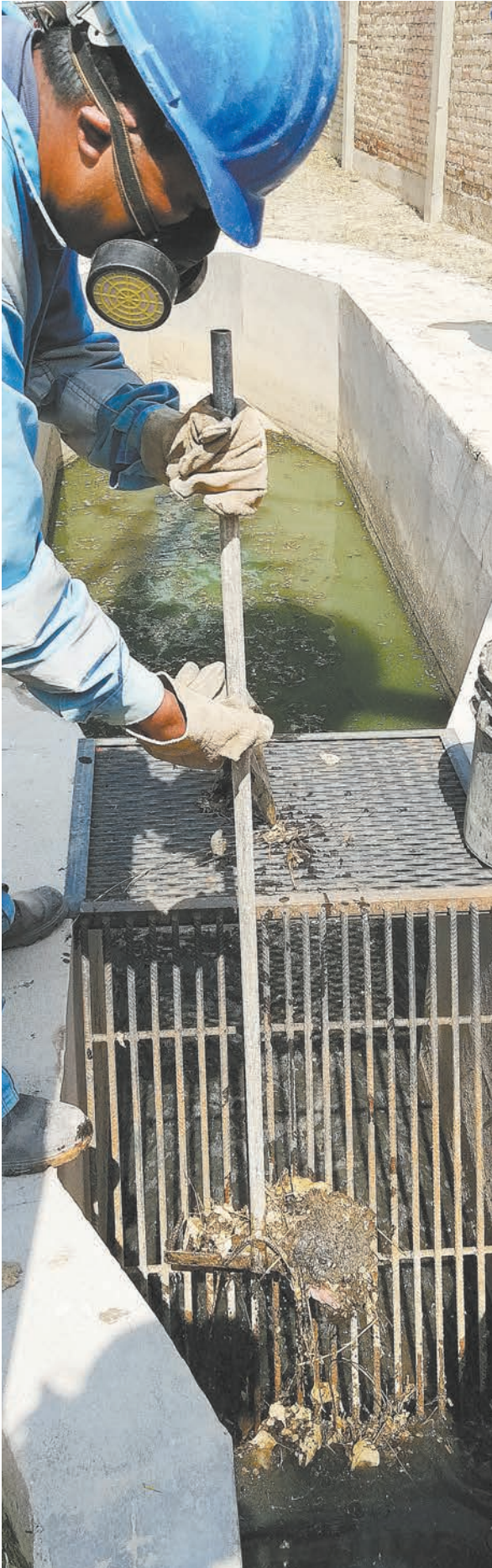
Trabajador en Villazón encaminando el tratamiento de aguas residuales .
