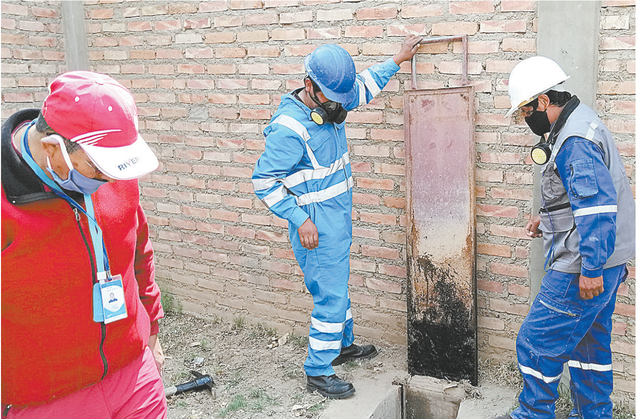
Trabajadores realizando su labor cotidiana en la planta de tratamiento de aguas residuales en Villazón.
